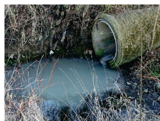
Einleitung von Abwasser in den Urbach (01/2016)
