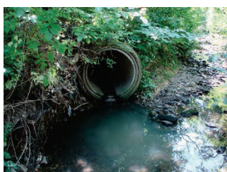
Einleitung von Abwasser in den Urbach (08/2015)
